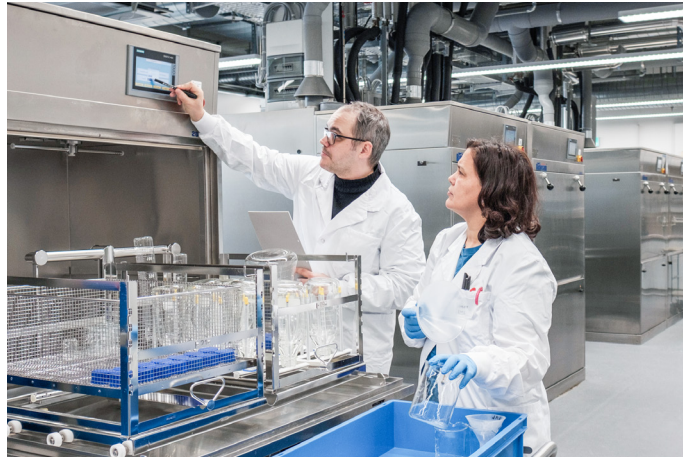
Die Aufbereitung von Labormaterialien in der zentralen Medien- und Waschküche des Biozentrums wird energieeffizienter gestaltet.
